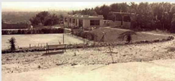
L'ancien court central à l'emplacement de la future piscine
